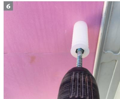
6 Spiraldübel mittels Schraubenkopf bündig eindrehen. Bei der Montage direkt an der Wand 10 mm Bohrung setzen und Dübel einschlagen. Bei Dämmungen kleiner als 10 cm Dübel leicht eindrehen und wieder entfernen. Spiraldübel entsprechend der Dämmstärke kürzen und erneut bündig eindrehen.
