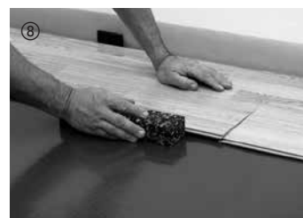
Bei Bedarf mit Schlagklotz leicht nachklopfen.
