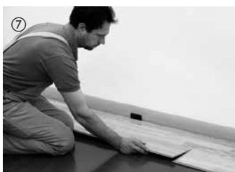
Mit dem Reststück der ersten Reihe wird in der nächsten Reihe wieder begonnen (stirnseitiger Versatz von mindestens 1/3 der Elementlänge, bei Landhausdielen XL mindestens 50cm). Dadurch wird der Verschnitt erheblich reduziert. Die weitere Verlegung erfolgt elementweise. Dazu werden die Elemente zuerst längsseitig mit leichtem Druck in die Verbindung eingedreht.
