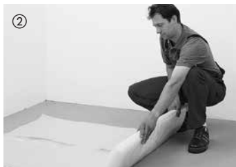
Grundsätzlich ist bei allen Estrichen und bei Verlegung auf Fußbodenheizung eine 0,2 mm starke PE-Folie – SD größer 75m auszulegen. Diese muss im Stoßbereich 30 cm überlappen. Anschließend die Folie auf Höhe des Bodenbelags abtrennen.
