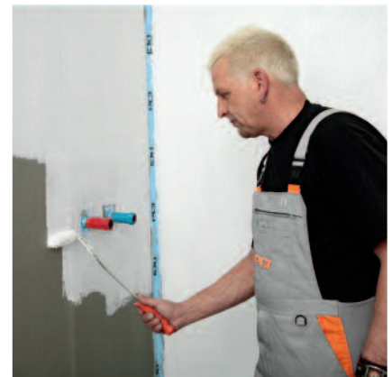
PCI Lastogum wird unverdünnt durch Rollen, Streichen oder Spachteln auf den Untergrund aufgebracht.
