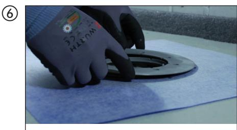
DE: Gegenflansch passend auflegen, mit beiliegenden Schrauben handfest befestigen. Beim Anziehen darauf achten, dass immer zwei diagonal gegenüberliegende Muttern nacheinander angezogen werden
