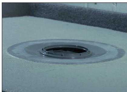
DE: Bodenablauf bereits gemäß Einbauanleitung im Estrich eingebracht.
