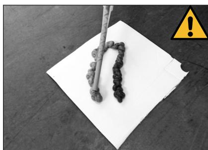
DE: Erst-Abstrich (20-25 cm) als Homogenisierungsprobe anfertigen und entsorgen. Sicherheits- und Verwendungshinweise des Klebemittelherstellers beachten.
