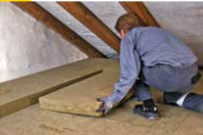
Bei einer zweilagigen Verlegung wird die zweite Lage mit versetzten Stößen quer zur ersten Lage verlegt. Dies erhöht die Dämmwirkung und verhindert zusätzlich Wärmebrücken.
