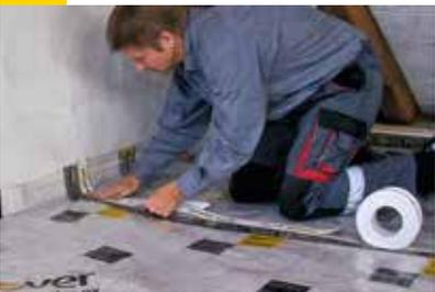
Die Folie bahnenweise verlegen. Die Überlappungen der Folienstöße sollten 10 cm betragen und werden mit Vario® KB 1, Vario® MultiTape + oder Vario® XtraTape verklebt. Eine gute Orientierung bietet der Aufdruck am Folienrand.
