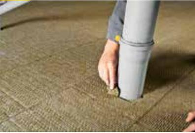
Bei Durchdringungen Dämmschicht sorgfältig schließen.
