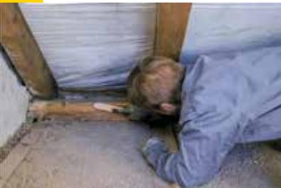
Vorbereitung: Reinigen der Anschlussbereiche an Wand und Holzbalken mit Drahtbürste und Staubsauger. Zum klebesicheren Anbringen von Vario® DoubleFit + oder Vario® ProTape +. Ggf. den Untergrund mit Haftvermittler Vario® MultiPrime vorbehandeln.
