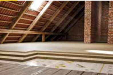
Holzbalkendecken: Die Klimamembran kann eben, von oben auf der Holzbalkendecke verlegt werden, wenn in der Bestandsdecke bereits verbaute dämmende Schicht nicht mehr als ca. 30% der Gesamtdämmwirkung abdeckt. Bei einer Bestandsdecke mit 80 mm Mineralwolle in WLG 040 oder 140 mm Strohlehm-Gemisch muss, zur Vermeidung von Tauwasserausfall, die Topdec Loft Platte in der Stärke von mindestens 140 mm verlegt werden.
