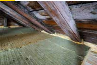
Bei Bedarf werden die Lücken in den Gefachen bis zu Schalung / UDB mit flexibler Glaswolle gefüllt, z.B. Integra ZKF 1-035.
