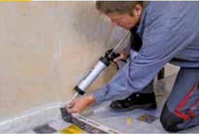
Zusätzliches Abdichten der Bahnenüberlappungen an den Wandanschlüssen mit dem Dichtstoff Vario® DoubleFit +.
