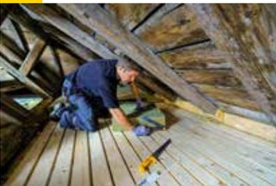
Neigungswinkel der Sparren mit einer Schmiege abnehmen und auf die Topdec Loft Platten übertragen, dann zuschneiden und möglichst genau angepasst verlegen.
