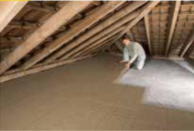
Betondecken: Rissfreie Betondecken im Bestand kommen aufgrund ihres hohen Diffusionswiderstands ohne dampfbremsende Schicht aus. Im Neubau ist die Dampfbremse ISOVER Difunorm mit einem festen sd-Wert von 100 m zu verlegen. Damit wird der Gehbelag oberhalb der Topdec Loft Platte von der Restfeuchte aus der frisch gegossenen Betondecke geschützt.
