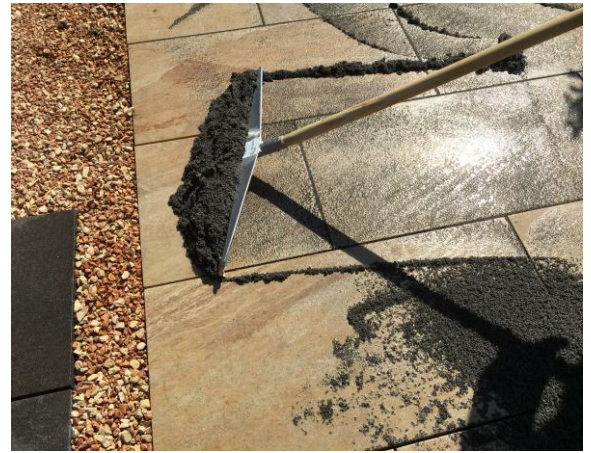
Abb. E: Einschlämmen von DOPOX® TYP SF
