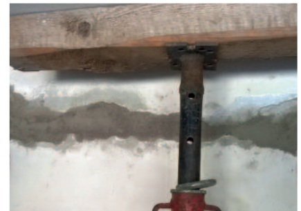
Unterstopfen eines Schlitzes in einer tragenden Wand mit PCI Repaflow USM
