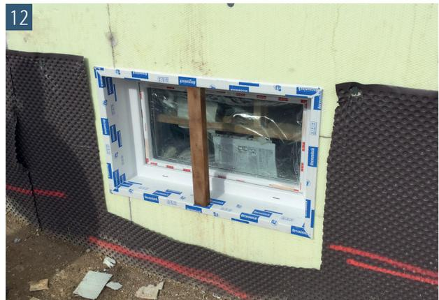
12 Während der Trocknung Aussteifen um Durchbiegung zu vermeiden
