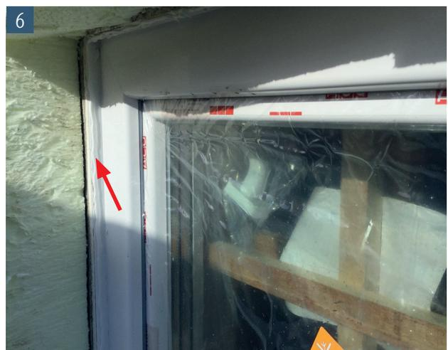
6 Dicht- und Klebstoff Superfix umlaufend auf die Stufe des Fensters auftragen
