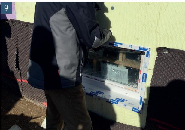
9 Dichtstoff an den oberen Kanten nacharbeiten und Fugen abziehen
