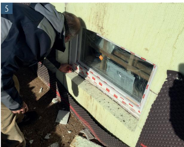
5 Schutzfolie entfernen und Aussparung säubern (grobem Schmutz rausfegen). Fensteroberfläche säubern (staub- und fettfrei)
