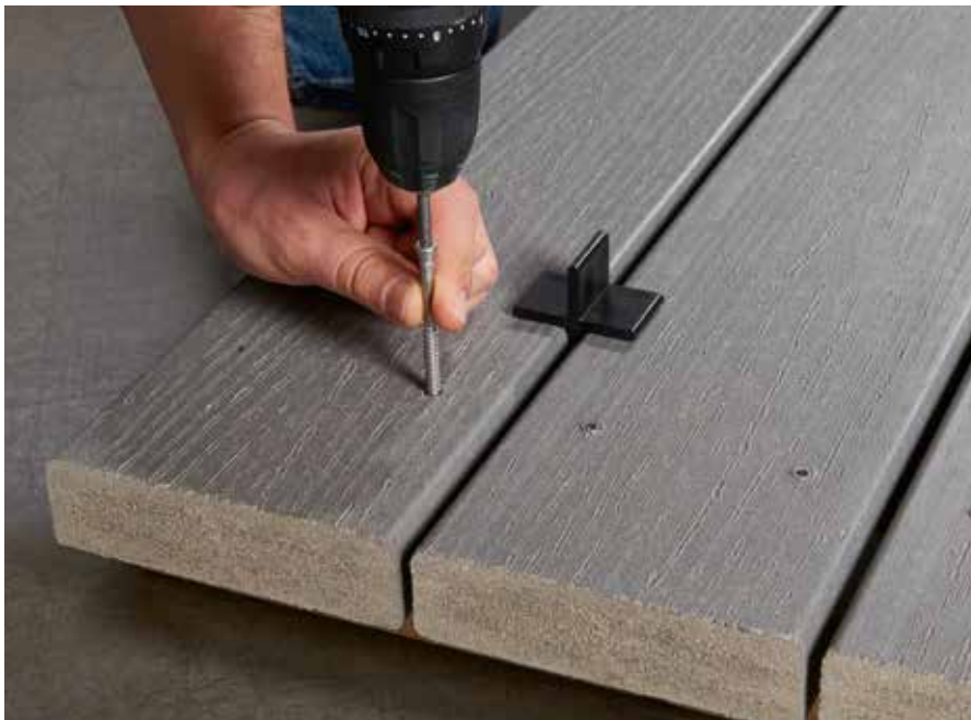
Verschraubung der Tragbohle
