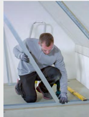
Um Schallbrücken zu minimieren, verlegen Sie zwischen Wand bzw. Decke und den Anschlussprofilen am besten zunächst ROCKWOOL Randstreifen. Nach dem Andübeln der Anschlussprofile werden die Ständerprofile eingestellt und ausgerichtet. Danach wird die Bekleidung aus Gipskartonplatten (GKB) auf einer Seite der Profile verschraubt.
