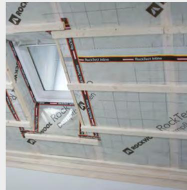
Vor die Dampfbremssfolie wird eine Lattung als Unterkonstruktion für die Beplankung auf die Sparren geschraubt. Der leichte Abstand zwischen den Latten muss bei einer Querverlegung der Gipskartonplatten 45 cm betragen.
