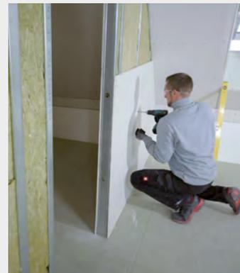
Anschließend wird die Bekleidung aus Gipskartonplatten mit dem Ständerwerk verschraubt. Zum Schluss sind noch die Plattenstöße der GKB-Platten zu verspachteln.
