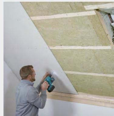
In diesem Bereich können Installationen oder Kabel verlegt werden, ohne die Dampfbremse zu beschädigen. Abschließend kann eine Wandbeplankung, z. B. aus Gipskartonplatten, angebracht werden.
