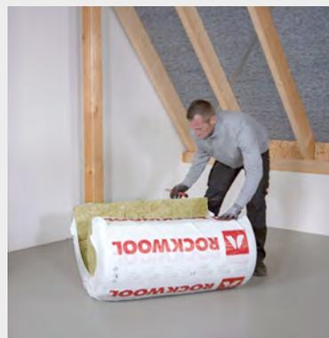
Die Folienverpackung einfach an der Klebestelle aufreißen. Klemmrock entrollt sich wie von selbst und entwickelt dabei die gesamte Dicke.
