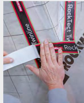
Für luftdichte Abschlüsse von Durchdringungen wird das Folienklebeband RockTect Twinline/Twinline FIRE verwendet. Dabei ist auf eine sorgfältige dichte Verklebung zu achten. Es empfiehlt sich, mit 5 bis 10 cm langen Klebestreifen zu arbeiten. Anschlüsse an Dachflächenfenster können ebenso ausgeführt werden.
