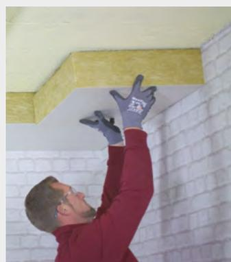
Danach die Dämmplatte mit der flachen Hand an die vorbereitete Decke drücken und fixieren. Planarock Top besitzt dank einer Vlieskaschierung bereits eine fertige Oberfläche. Sollte ein nachträglicher Farbanstrich gewünscht sein, ist die dazu speziell beschichtete Planarock Paint die richtige Wahl.
