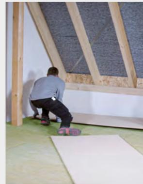
Anschließend kann die gedämmte Fläche z. B. mit Spanplatten belegt werden. Die Verwendung von Nut- und Federspanplatten ermöglicht einen sicheren Verbund der Decklage. Eine Verklebung der Plattenfugen ist nicht erforderlich.
