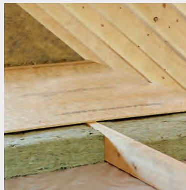
Bei Dachböden, die als Abstellraum genutzt werden sollen, wird Klemmrock zwischen den ausgelegten Kanthölzern ausgerollt und mit Spanplatten abgedeckt.
