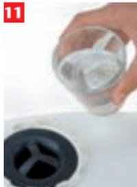
10 Anschließend kann der Geruchsverschluss wieder in den Befestigungsring gedrückt werden. Den Geruchsverschluss mit Wasser füllen
