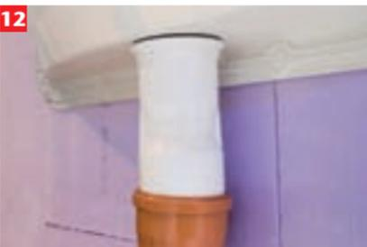
KG-Rohr DN 100 muffenseitig anschließen. Dichtung mit Gleitmittel bestreichen. Das KG-Rohr muss im weiteren Verlauf im Gefälle zum Kanal verlegt werden
