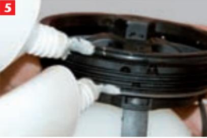
5 Nach dem Reinigen alle Dichtungen auf Reinheit und Beschädigungen untersuchen. Beschädigte oder fehlende Dichtungen führen zur Fehlfunktion der Rückstaeinheit. Beschädigte Dichtungen austauschen! Dichtungen an der Rückstaeinheit mit Gleitmittel bestreichen (wie bei Montage)
