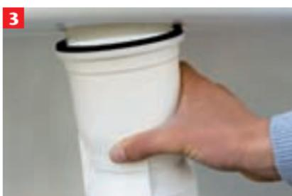
Den Einschraubring von oben durch die Lichtschacht-Entwässerungsöffnung führen. Den Grundkörper von unten auf den Einschraubring schrauben, dabei auf den korrekten Sitz des Gewindes achten, Grundkörper soweit aufschrauben, bis die Dichtung am Lichtschacht anliegt. Mit dem Einschraubring festziehen, dabei den Grundkörper gegenhalten
