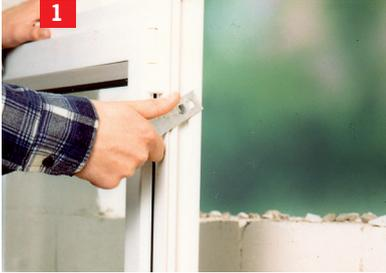
Je nach Befestigungsmethode entweder in jeder Fensterecke Befestigungsanker eindrehen oder im Blendrahmen seitlich Löcher bohren (Eckenabstand ca. 15cm).
