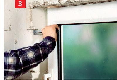
Flügel ausbauen. Durch den Maueranker bzw. den Blendrahmen in das Mauerwerk bohren und verschrauben. Flügel wieder einsetzen.
