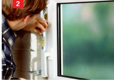
Das Fenster in die Maueröffnung stellen, mit der Wasserwaage ausrichten und in den Ecken mit Keilen fixieren. Anschließend vorsichtig eine Funktionskontrolle durchführen.
