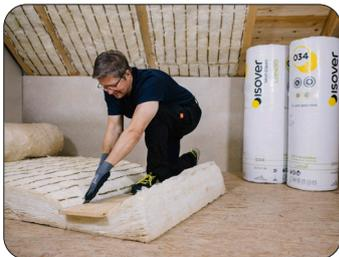
Der Untersparrenklemmfilz wird liegend entlang einer Führung zugeschnitten. Das Schnittmaß (Lichter Sparrenabstand + 0,5 cm) ist entsprechend der Führung einzustellen. Zur Schnittführung kann ein mindestens 10 cm breites Brett als Hilfsmittel eingesetzt werden. Mit dem Eigengewicht den Dämmstoff komprimieren und zuschneiden. Achtung: Eine schmale Dachlatte ist als Schneidhilfe nicht geeignet. Es besteht sonst Verletzungsgefahr!
