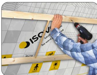
Gemäß ZVDH-Richtlinien müssen Wärmedämmungen so eingebaut werden, dass die Lagesicherheit und Funktion dauerhaft gewährleistet sind (z.B. mit Holzlatten 30 x 50 mm, 40 x 60 mm oder 60 x 60 mm). Der Abstand richtet sich nach der Art der Innenbekleidung. In der Dachschräge an der Decke (waagrecht) sollte ein Abstand von 400 mm nicht überschritten werden. Tipp! Bei der Montage der Querlattung ist eine Abstandshilfe hilfreich.
