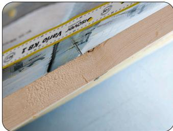
Wird der Abstand der Latte zum Sparren zu groß, und die Zwischensparrendämmung drückt auf die Dampfbremse, muss eine weitere Latte in passender Abmessung zur Lagesicherung direkt auf den Sparren verlegt werden. Dies verhindert Spannungen an den Tackerstellen und den Klebeverbindungen.
