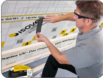
Sind die Sparren der Dachschräge nicht in einer Flucht, so kann die Traglattung z.B. über Stellschrauben ausgeglichen werden. Um zu verhindern, dass die Folie am Gewinde aufgerieben wird, sollte zuvor im Sparrenbereich auf die Dampfbremse das Nageldichtband Vario® AntiSpike aufgeklebt werden. Dies kann dann durch Antackern zusätzlich am Sparren fixiert werden. So ist die Durchdringung der Folie luftdicht. Alternativ zu den Stellschrauben eignen sich auch RIGIPS U-Direktabhänger 125.
