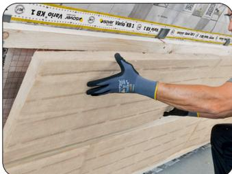
Der Untersparren-Klemmfilz Integra UKF-031 kann jetzt bündig mit der Lattenunterkante endgültig in die richtige Position gebracht werden. Um Wärmebrücken zu verhindern und eine dauerhaft schadensfreie Konstruktion zu gewährleisten, sollte der Untersparrenklemmfilz lückenlos und mit kompletter Dämmstoffdicke eingebaut werden.
