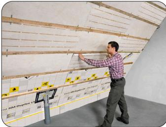
Liegt die Dampfbremse zwischen den Dämmschichten, dürfen pauschal nach ZVDH maximal 20% des Wärmedurchlasswiderstandes unter der Dampfbremse liegen. Dieser Anteil kann mit dem Einsatz der ISOVER Vario® Klimamembran durch ihr Rücktrocknungsvermögen auf etwa ein Drittel ohne rechnerischen Nachweis ausgeweitet werden. Ausführungsvarianten finden Sie in der Broschüre «ProfiWissen Dach» unter Kapitel Ergänzende Untersparrendämmung.
