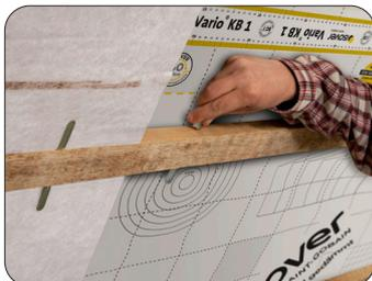
Der Integra UMB Untersparren-Montagebügel wird hinter die Latte eingeschoben. Die beiden Flügel fixieren den Untersparren-Klemmfilz bis die Innenbekleidung montiert wird.
