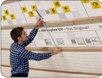
Bei der anschließenden Montage der Innenbekleidung, z.B. Rigips Bauplatten mit einer Länge von 2000 mm oder 2500 mm, sollten Achsabstände von 500 mm für die Holzunterkonstruktion eingehalten werden. Die Platten werden dann hochkant an die Holz-Unterkonstruktion verschraubt. Die Holzlatten sollten der Sortierklasse S 10 nach DIN 4074 Teil 1 mit einer Restfeuchte unter 20 % entsprechen.
