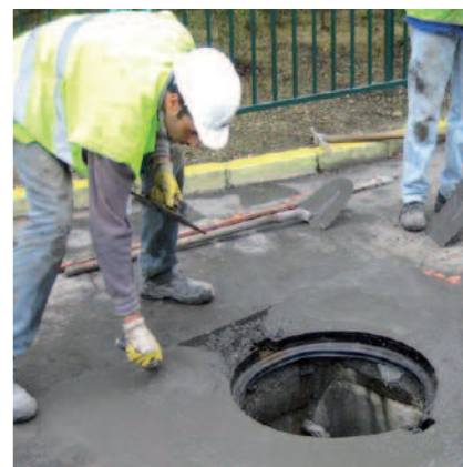
Einbetten eines Schachtringes mit PCI Repafast Tixo
