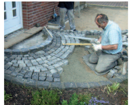
Verlegen von Kleinpflaster in PCI Pavifix DM.
