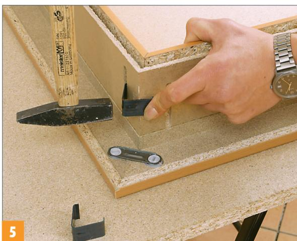
Schlagen Sie die Stahlklammern in die Nuten. Die Gehrungsschutzecken der Bekleidungen stecken Sie oben in den Zwischenraum, so dass die Wangen ...
