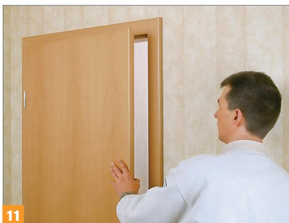
Hängen Sie dann provisorisch die Tür ein und kontrollieren Sie, ob sie sich öffnen und schließen lässt. Anschließend hängen Sie die Tür wieder aus und...
