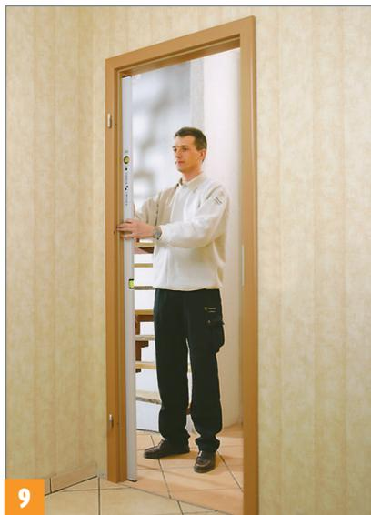
Die Zarge muss nun ausgerichtet werden. Verwenden Sie eine möglichst lange Wasserwaage/Richtlatte und kontrollieren Sie Innen- und Außenseite.
