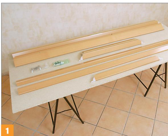
Der Zusammenbau der Zarge erfolgt am besten auf einem großen Tisch oder wie hier auf zwei Böcken, über die eine Holzplatte gelegt wurde.
