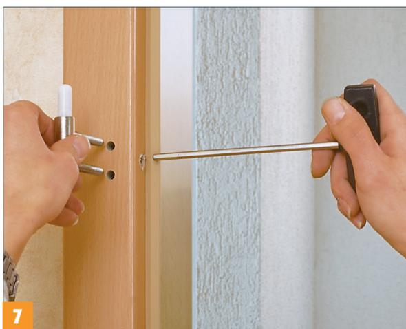
Richten Sie die Zarge nun auf und stecken Sie die Scharniere in die Bohrungen oben und unten. Von der Innenseite lassen sie sich feststellen.
