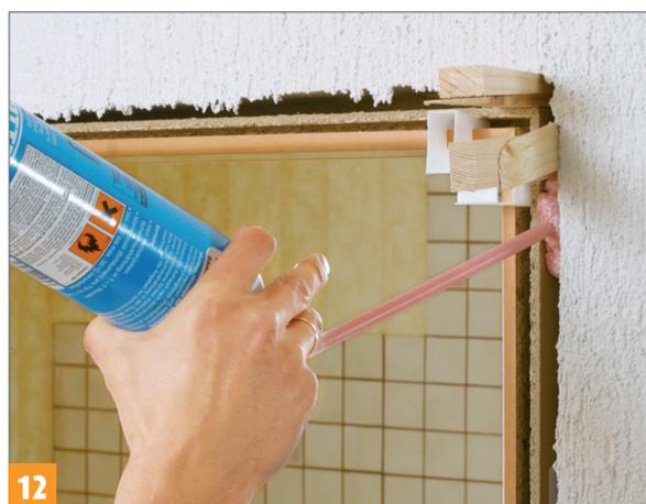
... verstellen gegebenenfalls die Spreizen. Passt alles, schäumen Sie mit 2-Komponentenschäum die Hohlräume zwischen Zarge und Wand aus.
