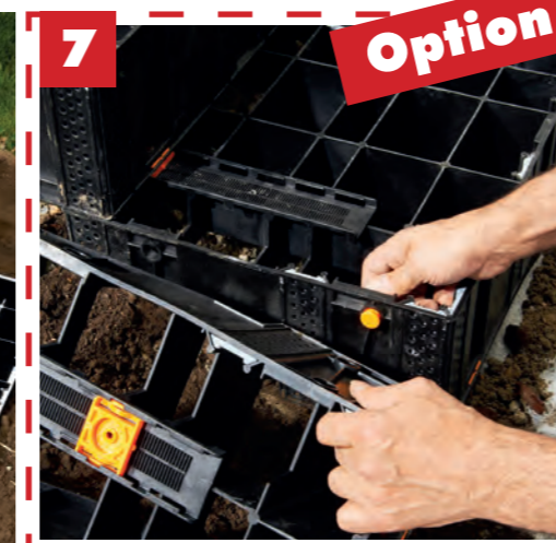
Die weiteren Stufen in die Schienen schieben ...
