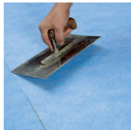
Bahnen mit Traufel, Gummiwalze oder Klopfbrett andrücken.
