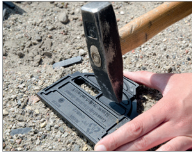
1. Optional können die Vorformungen herausgeschlagen werden. Dadurch ist ein Ablauf auch über die Kombi-stirnwand möglich
