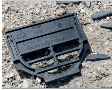
2. Herausschlagen der fünf gekennzeichneten Bereiche der Stirnwand mit dem Hammer
