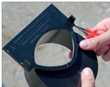
4. Der herausgeschnittene Bereich Y ermöglicht den maximalen Ablaufquerschnitt
