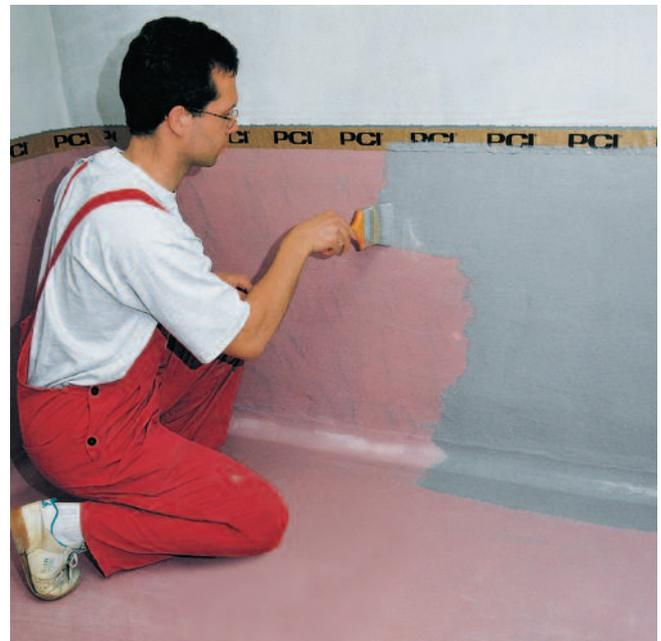
Da für eine öldichte Beschichtung mindestens eine Grundierung und zwei Deckanstriche erforderlich sind, ist nach weiteren ca. 8 Stunden Trocknungszeit der zweite Deckanstrich mit PCI Visconal (grau) aufzutragen.
