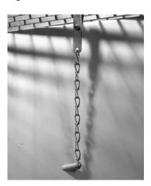
Lichtschachtrost einsetzen und Rostabhebesicherung einbauen. Ggf. Entwässerungsöffnung mit ACO Lichtschacht-Verschluss schließen oder ACO DWD Entwässerungsanschluss einsetzen.
