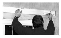
4. Die Lage des Lichtschachtes bestimmen, halten Sie dazu den Lichtschacht mit eingelegtem Rost an die Wand und kennzeichnen die Position der beiden oberen Bohrungen. Dabei sollte der Abstand von der Fensterunterkante bis zum Lichtschachtboden >= 15cm betragen. (gem. DIN 18195) Oder verwenden Sie die ACO Montagehilfe.
