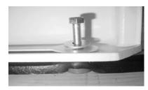
10. Lichtschacht mit den beiden oberen Schrauben fixieren. Die restlichen Schrauben einsetzen. Die Schrauben mit einem Hammer durch das Dichtband schlagen. Die Schrauben nach und nach handfest anziehen. Nach ca. 1 Stunde die Schrauben nachziehen. Dabei Dichtfix bis auf ca. 5 mm Stärke zusammendrücken.
