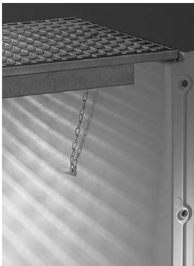
1. Lichtschachtrost einsetzen und Rostabhebesicherung einbauen.
