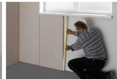
Platte im Endlosverfahren stoßversetzt direkt auf das Mauerwerk oder den tragfähigen Putz aufkleben, dabei Kreuzfugen vermeiden.
