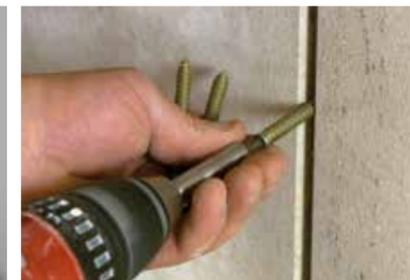
Im Bereich der Feder mit versenkbaren Rahmenschrauben mechanisch sichern ...
