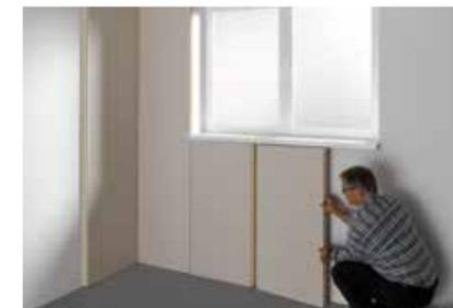
... und die nächste Dämmplatte einstecken.
