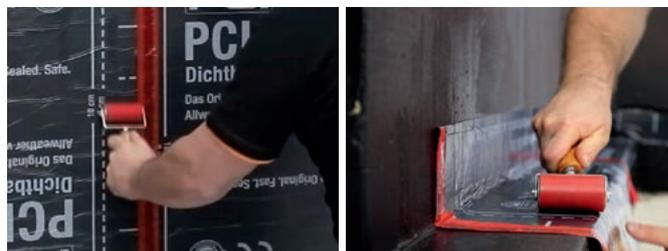
Einfach ankleben: Sauberes, schnelles Verarbeiten zeichnet PCI BT 21 aus. Auch Ecken und Unebenheiten lassen sich mit der Dichtbahn einfach ausführen.
