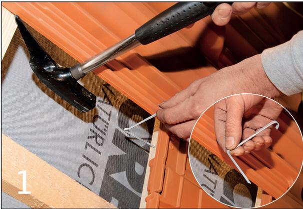
Die Einschlagklammer wird mit dem Nagel in die Traglattung eingeschlagen und mit dem U-Schenkel in die Seitenverfaltung des CREATON Tondachziegels befestigt.
