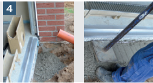
4 Einbringen des Rinnenfundamentes gemäß Einbauempfehlung. Verdichten des Rinnenfundamentes. Vorbereiten des Ablaufes für KG-Rohr DN/OD 110
