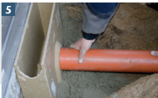
5 KG-Rohr mit Gleitmittel in den Einlaufkasten einsetzen. Optional: Geruchsverschluss verwenden
