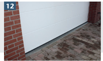
12 Der fertiggestellte Rinnenstrang in der Pflasterfläche vor der Garage entlastet die Schwelle und verhindert aufspritzendes Wasser im Torbereich
