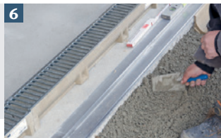
6 Lösen Beton auf das bereits verdichtete Fundament aufrbringen
