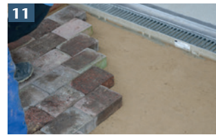
11 Pflaster an den Rinnenstrang anarbeiten
