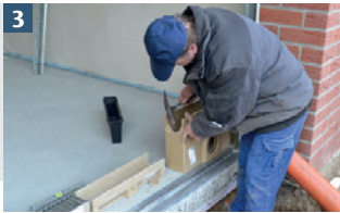
3 ... und von außen nach innen mit einem Hammer ausschlagen
