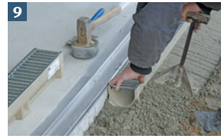
9 Seitliche Betonstütze gemäß Einbauempfehlung herstellen
