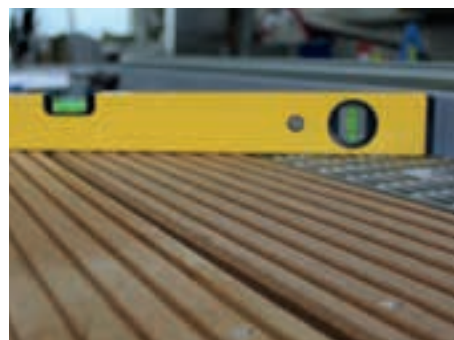
Kontrolle der Einbauhöhe
