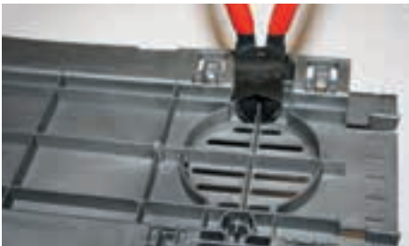
Durchtrennen der vier Stege von unten
