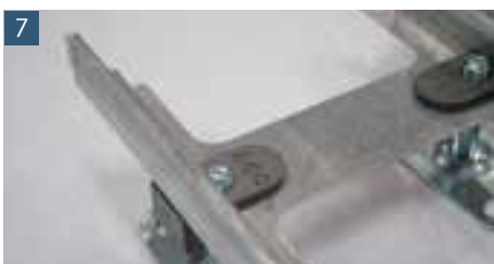
7 Nach dem Einsetzen von min. 4 Füßen kann die Frameline verbaut werden
