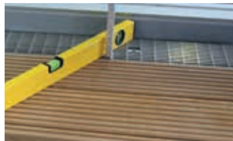
Einpassen der Holzterrassenrinne
