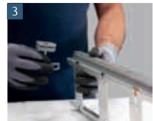
3 Kunststoffblock mit vormontierten Fuß in die entsprechende Nut bis zum Anschlag einsetzen
