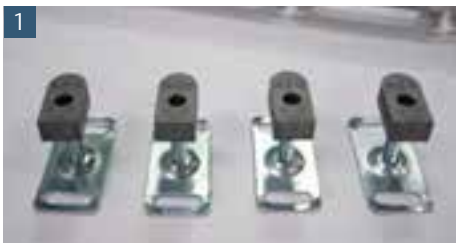
1 Vormontierte Höhenversteller bereitlegen
