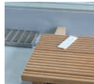
Rinnenkörper nach Notwendigkeit bau-seits unterfüttern
