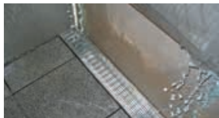
Beregnung der Fassadenrinne im Einbau
