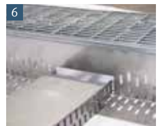
Den Stichkanal durch einfaches Öffnen der Kiesleiste ansetzen
