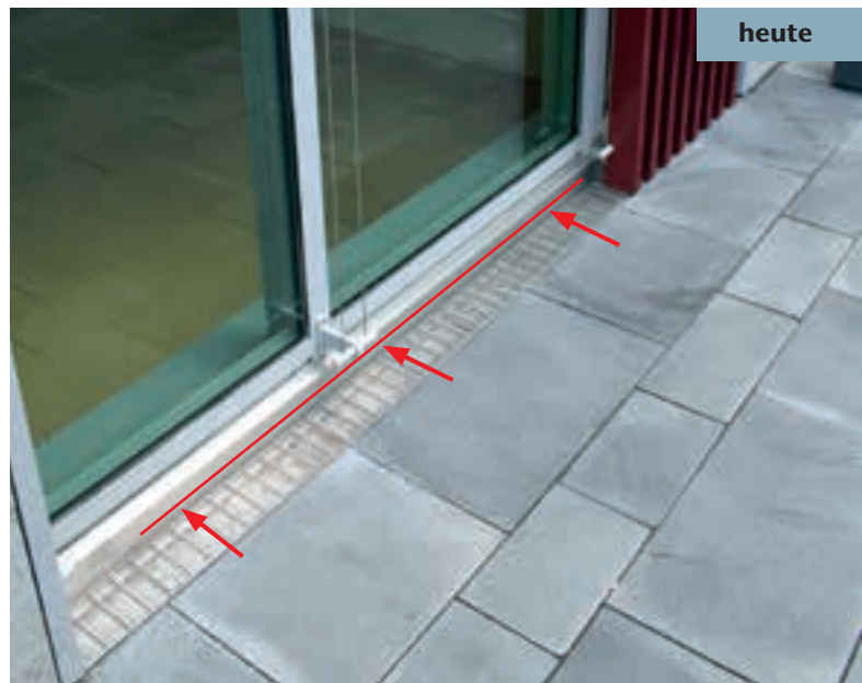
ACO Keilrinne: passgenau vor Fassaden- oder Türanschluss ohne zusätzlichen Kiesstreifen
