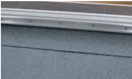
Anschluss einer bituminösen Abdichtung mit Keilausbildung
