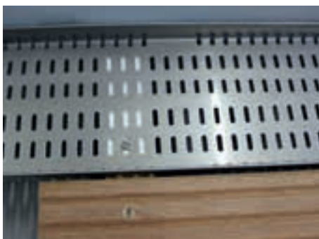
Verschraubung des Rinnenkörpers durch die 4-mm-Dränschlitz im Rinnenboden
