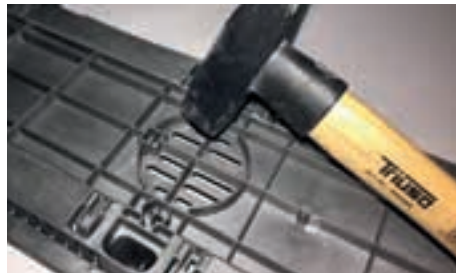
Ausschlagen der Bereichs für den Einsteckstutzen
