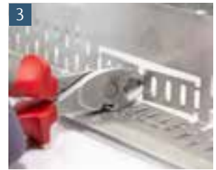
Den Stichkanal durch einfaches Öffnen der Kiesleiste ansetzen
