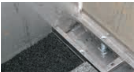
Rinnensystem lose verlegt a
