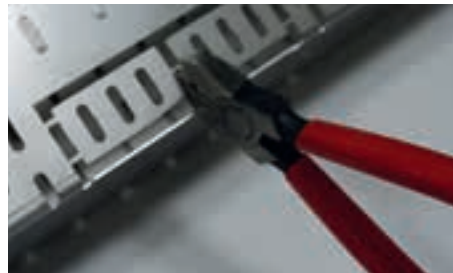
Öffnen des Stichkanalanschlusses
