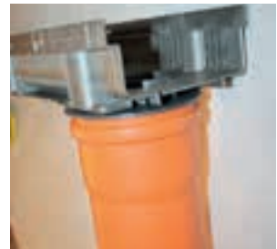
Anschließen des KG-Rohres DN 100
