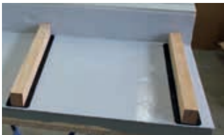
Verlegen der Lagehölzer auf der Abdichtung. Empfohlener Abstand für den Rinnenkörper sind 50 cm
