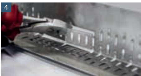
Die entsprechende Kiesleiste wird lose vor die Frameline gestellt
