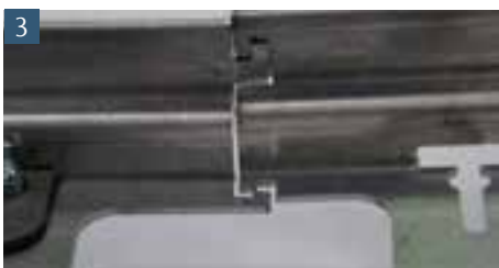
Die feste Nut- und Federverbindung wird durch einfaches einschwenken der Elemente hergestellt
