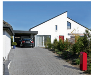
Fachgerechter Einbau unter einer Pkw-Stellfläche mit einer Erdüberdeckung von 100 cm
