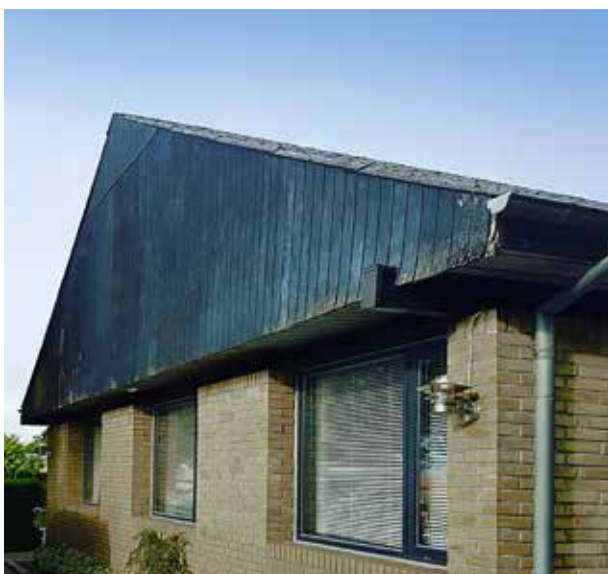
Vor der Renovierung
