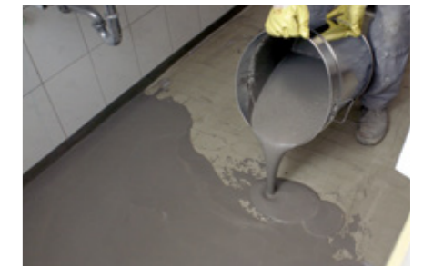
Unterbau: 1. Untergrund im Bestand (sauber und tragfähig) z.B. Estrich, alter Fliesenbelag, Holzdielen
