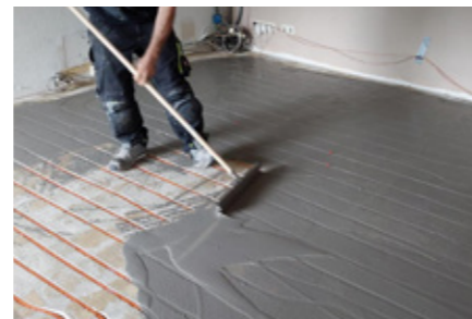
Unterbau: 1. Untergrund im Bestand z.B. Estrich (sauber und tragfähig) Altbeläge entfernen, saubere Estrichoberfläche herstellen
