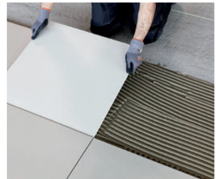
Verlegen von Feinsteinzeugplatten.
