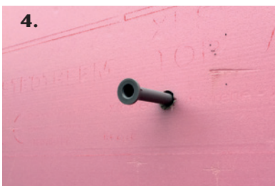
14 mm Bohrungen entsprechend der Dübellänge setzen und Dübel bündig einschlagen
