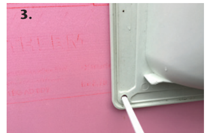
Links und rechts 2 weitere Befestigungspunkte anzeichnen und Lichtschacht wieder von der Wand nehmen
