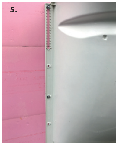
Schrauben mit Beilegescheiben bestücken und Lichtschacht mit eingelegtem Rost montieren. Rostabhebesicherung in Tragstab des Rostes (Langloch) einhängen und Kette im Lichtschacht befestigen. Siehe Abbildung Punkt 8 auf nachfolgender Seite
