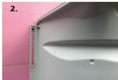
Lichtschacht mit eingelegtem Rost über die beiden oberen Befestigungspunkte montieren. Gegebenenfalls Höhe justieren
