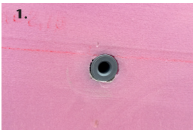
Die oberen beiden Befestigungspunkte des Lichtschachtes anzeichnen, 14 mm Bohrungen entsprechend der Dübellänge setzen, Dübel bündig in Dämmung einschlagen
