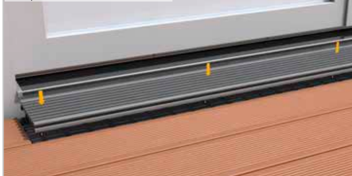
Rost parallel zu den Dielen einsetzen
