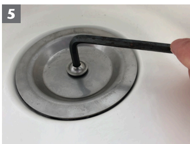
5 Schraube mit Inbusschlüssel fest anziehen. Deckel muss zentriert auf dem Dichtungsring aufliegen.
