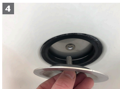
4 Oberen Deckel mittels Schraube mit dem unteren Deckel verschrauben
