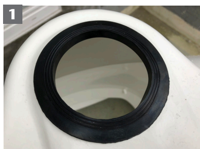
1 Dichtungsring über Dichtungsnut in Entwässerungsöffnung einsetzen
