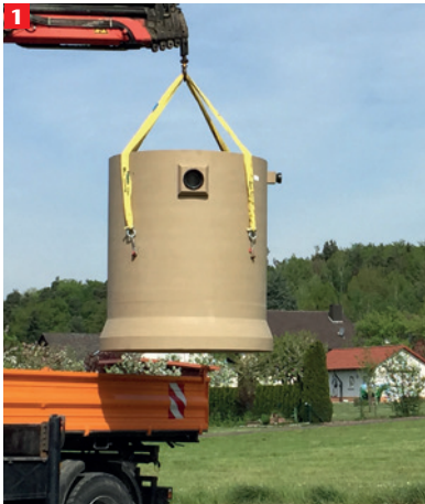
1 Abladen des Polymerbetonbehälters
