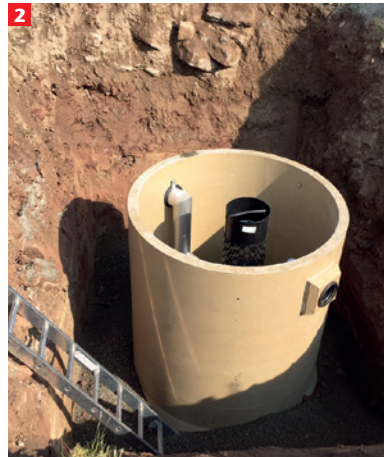
2 Setzen des Behälters in die Baugrube
