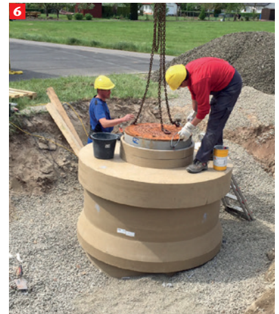
6 Verkleben der Schachtabdeckung
