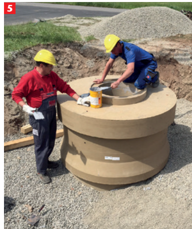
5 Verkleben von Auflagerringen
