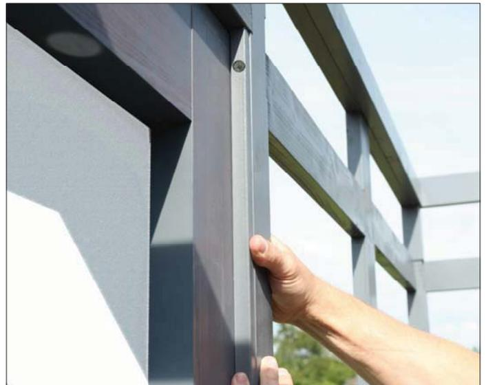
Schließen Sie nun die Tür, richten die Frontwand parallel zur Tür aus und dübeln Sie diese dann mit der Schwelle am Fundament an. **(Dübel sind nicht im Lieferumfang enthalten!)**
