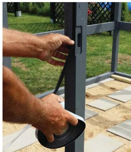
Bekleben Sie das Grundgerüst mit dem EPDM Dichtband A109 (9mm breit) und A111 (30mm breit). Verwenden Sie für die Bereiche in denen 2 Platten aneinander stoßen A111 und für die Ober- und Unterseite des Gerüstes A109. Das Dichtband muss ohne Abstand dicht auf Stoß geklebt werden um eindringendes Wasser zu verhindern. In den Eckbereichen kleben Sie das Dichtband zu gleichen Teilen um die Ecke. Halten Sie oben einen Abstand von 0,5cm bis zur Kante!
