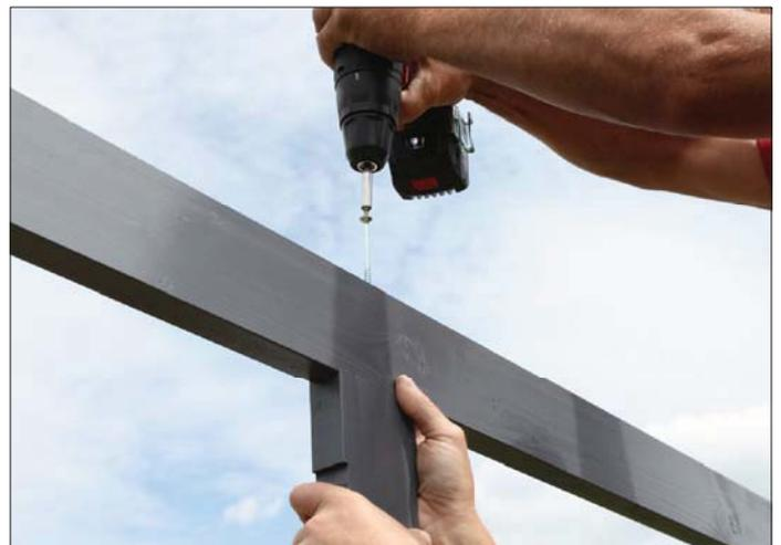
Fügen Sie nun die Mittel- und Eckpfosten in die jeweiligen Vertiefungen der Rähm, bohren Sie vor und verschrauben Sie die Rähm mit den Schrauben 2x C105-0150 von oben und mit den jeweiligen Pfosten.
