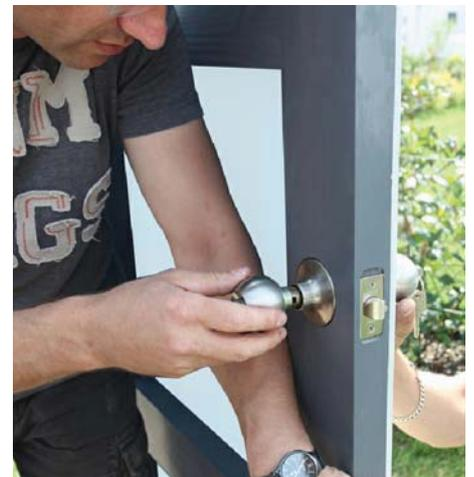
Positionieren Sie nun das messingfarbene Metallunterteil exakt mittig in der Aussparung um es mit den Außenteil des Schlosses mit Hilfe der beiliegenden Schrauben zu verschrauben. Klipsen Sie nun den Edelstahlsockel auf das Metallunterteil und stecken den inneren Drehknauf auf. Dazu drücken Sie mit dem kleinen Metallstift die Feder hoch damit der Knauf einrasten kann.
