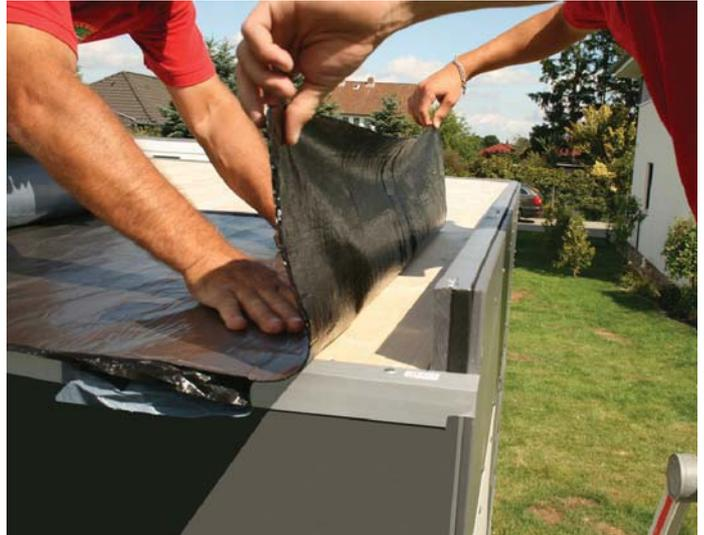
Verlegen Sie nun die selbstklebende Dachbahn. Das Verlegen der Bahn erfolgt quer zum Gefälle. Rollen Sie ca. 100cm der Folie ab und lassen Sie die Schutzfolie zum genauen Ausrichten der Bahn vorerst dran. Erst nach dem genauen Ausrichten ziehen Sie die Schutzfolie auf ca. 10cm ab und fixieren Sie die Bahn genau.
