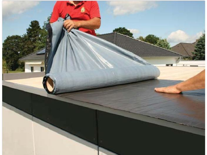
Lassen Sie auch über den Rand hinaus genügend Folie überstehen um einen guten Randabschluss zu gewährleisten. Nach dem vollständigen Verkleben der ersten Bahn nehmen Sie nun die zweite und lassen sie ca. 20cm überlappen. Durch Anwalzen besonders im Überlappungsbereich gewährleisten Sie eine gute Verklebung.
