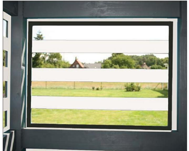
Bringen Sie nun das EPDM Dichtband A109 als Abdichtung von innen als seitlichen Streifen an den Fensterfassadenplatten an. (Beginnen Sie direkt im Anschluß an die Öffnungen). Danach kleben Sie die fehlenden Streifen oben und unten passgenau ein.
