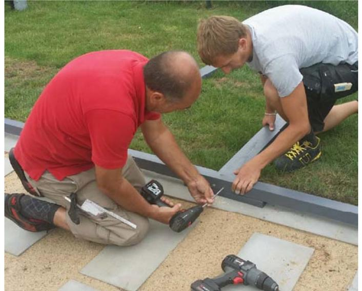
Legen Sie die Schwellen seitlich, bohren Sie die Schraublöcher mit einem 4mm Holzbohrer vor um dann die Mittelpfosten an der vertieften Aussparung von unten durch die Schwelle mit 2x C105-0100 anzuschrauben.
