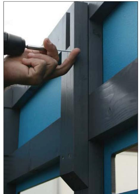
Verschrauben Sie die 4 Pfettenschuhe nach dem Vorbohren mit jeweils 4x C105-0060 von innen an den Mittelpfosten.
