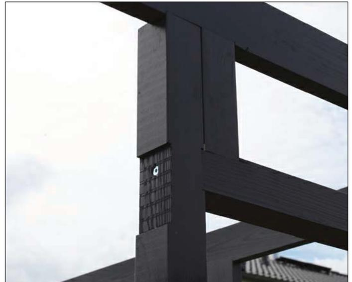
Positionieren sie nun das kurze, senkrechte Holz linksseitig über dem Sturz, bohren vor und verschrauben es mit 2x C105-0100 von innen am Pfosten.
