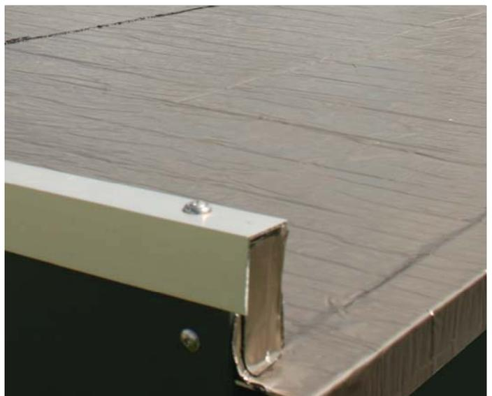
Nach dem Verkleben und Anwalzen der Dachbahnen schneiden Sie die Randbereiche mit einem Cutter passend.
