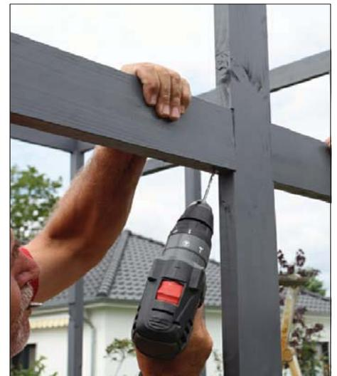
Nun platzieren Sie den ersten Riegel an der dafür ausgesparten Stelle und verschrauben diesen nach dem Vorbohren mit je 1x C105-0150 einmal gerade durch den Pfosten in den Riegel und einmal schräg von unten durch den Riegel mit 1x C105-0100 in den Pfosten. Schrauben Sie mit einem Abstand von 4cm schräg in den Pfosten.
