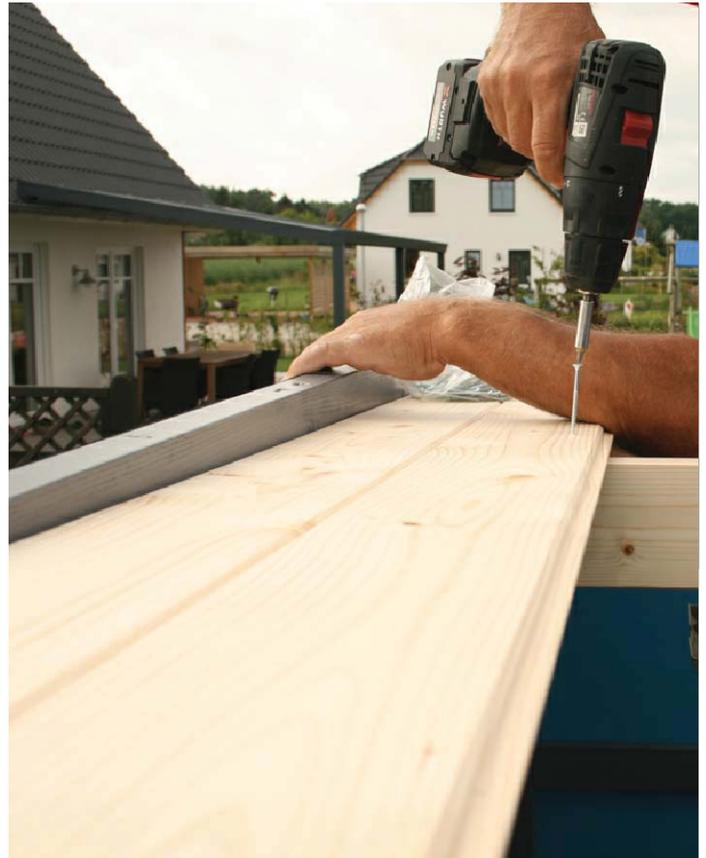
Verschrauben Sie die Profilschalungsbretter nach dem Vorbohren mit jeweils 2x C105-0040 vorne auf dem Kantholz hinter der Rähm, auf den beiden Pfetten und auf der Rähm hinten. Die Dachschalung wird an der Rückseite des Gebäudes überstehen um ggf. die Montage einer Regenrinne (optional) zu erlauben.
