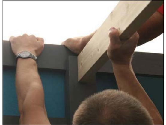
Um die genaue Lage der Pfetten und der Pfettenschuhe zu ermitteln, legen Sie ein Dachbrett hochkant vom Auflager vorne bis über die hintere Rähm. Zeichnen Sie dann die Oberkante der Pfette an und ermitteln so genaue Lage der Pfettenschuhe.
