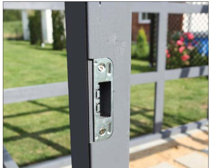
Positionieren Sie dann den Beschlag für das Schloß in der Aussparung am linken Türpfosten und verschrauben sie diesen nach dem Vorbohren mit 2 der dem Schloß beiliegenden Schrauben.
