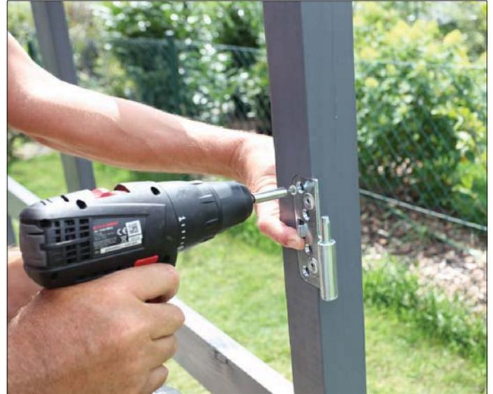
Schrauben Sie die drei Beschläge des rechten Türpfostens nach dem Vorbohren mit je 4 der beiliegenden Schrauben an die dafür vorgesehenen Aussparungen.
