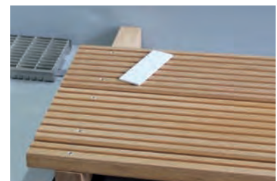
Rinnenkörper nach Notwendigkeit baureits unterfüttern
