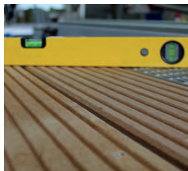
Kontrolle der Einbauhöhe
