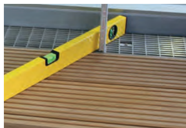
Einpassen der Holzterrassenrinne
