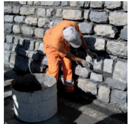
Pavifix CEM ROC für die Verfugung von waagerechten und senkrechten Fugen
