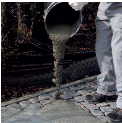
Beim Schlammverfahren lässt sich PCI Pavifix CEM mit einem Gummischieber leicht in die Fugen einbringen.
