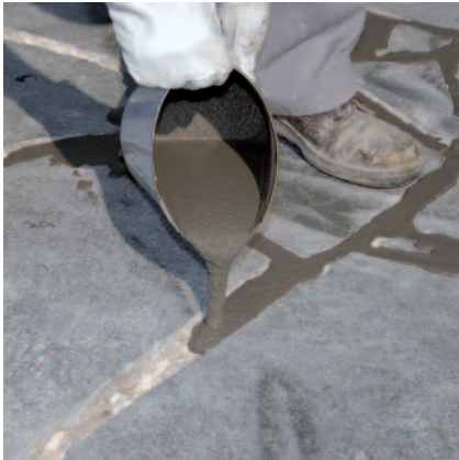
Pavifix CEM mit einem geeigneten Gießgefäß in die vorbereiteten Fugen einbringen.
