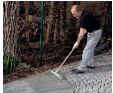
Beim Schlammverfahren lässt sich PCI Pavifix CEM leicht mit einem Gummischieber in die Fugen einbringen.
