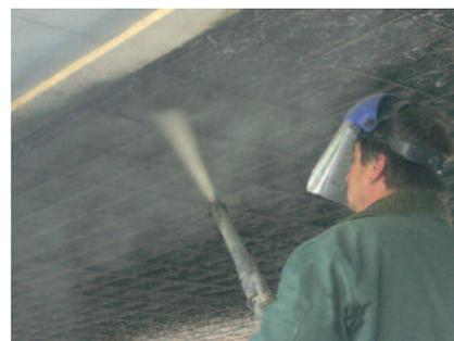
PCI Nanocret R4 SM ist ein hochfester Instandsetzungsmörtel, der sowohl händisch als auch gespritzt hervorragend im Überkopfbereich aufgebracht werden kann.
