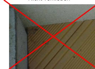
Lassen Sie eine 5mm Fuge zwischen den Lagerhölzer und dem Mauerwerk
