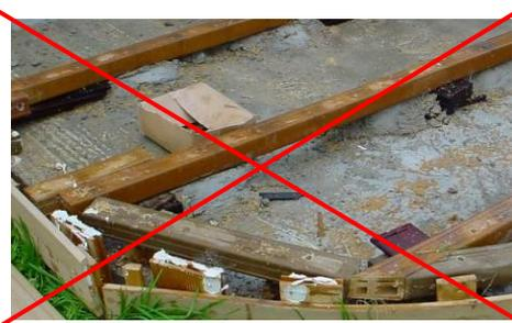
Lassen Sie 10mm Fugen zwischen den Lagerhölzer
