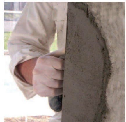
Instandsetzung von Ecken und Kanten - nur eine der vielen Einsatzmöglichkeiten des universellen Reparaturmörtels PCI Nanocret R2.
